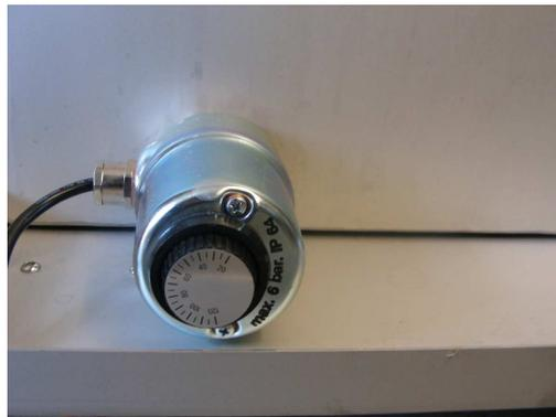
Abbildung 8: Einstellung der Heizpatrone hinten am Außenbehälter
